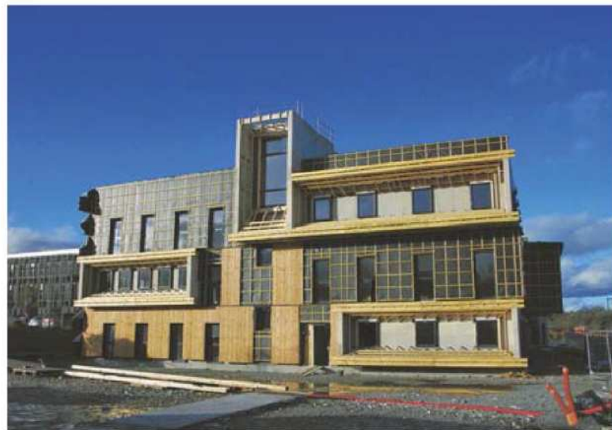
Le chantier de l'extension du Stériad, bâtiment de bureaux à Bain-de-Bretagne, est en cours, Vignault x Faure Architectes.
