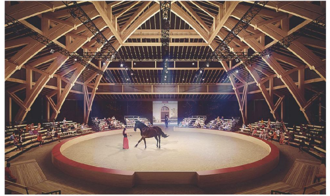
La halle en bois et ardoise d'une surface de 1464 m 2 , dédiée aux spectacles équestres et à la formation, pourra être ouverte ou close.
